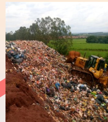
Compactação dos resíduos
